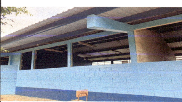
Foto 3: Se sustituirán las ventanas y colocar nuevas balcones
