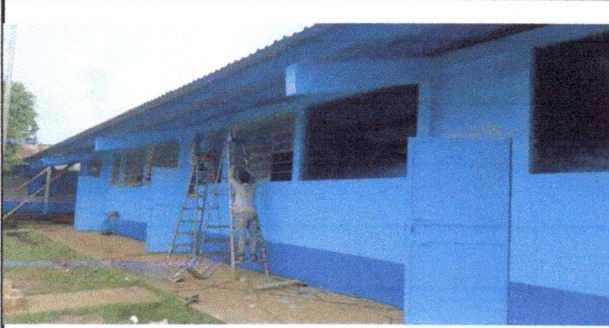
Foto 1: Se sustituirán las ventanas deterioradas por balcones de metal para mejorar la ventilación e iluminación dentro del aula.
