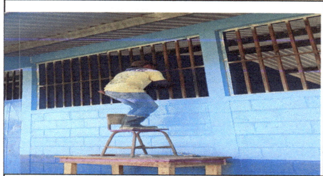
Foto 2: Se observa la pintura y darles un aspecto nuevo y así mejorar el ambiente dentro del aula. Del módulo 2
