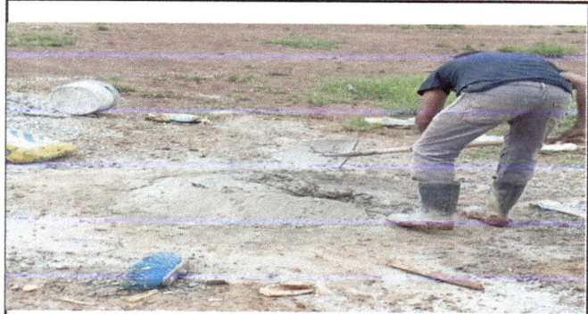
Foto 4: Reparación de mezcla del repello
