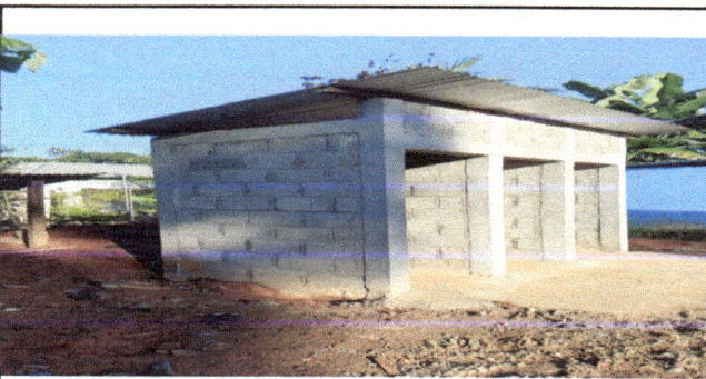
Foto 5: Se observa de repello del baños
